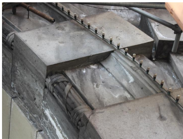
Figura 10 Particolare dei conci dell'arco
